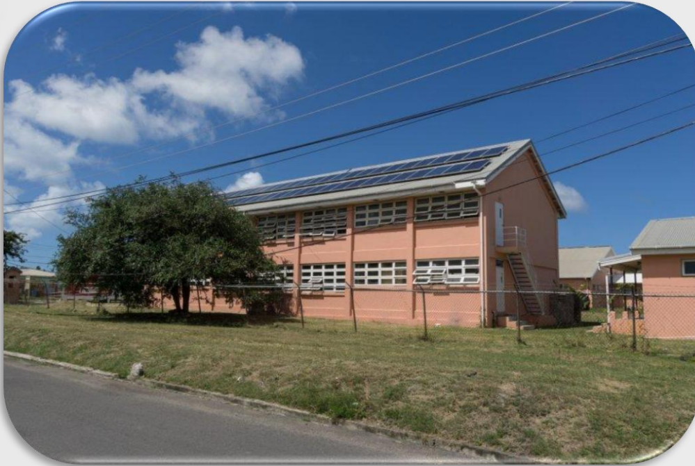
500kw Solar System Antigua year 2017
